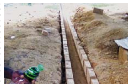
Bau der neuen Regenabflussrinne
