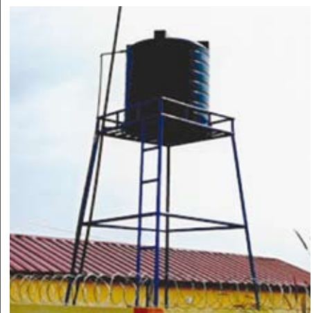
Der neue Wasserturm
