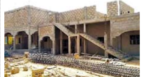
Integrativer Kindergarten und Internatsbau in Tibiri
