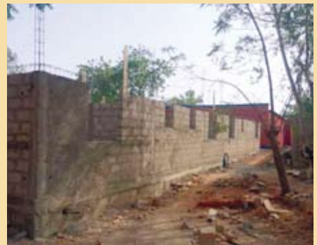
Fortschritte beim Bau der Augenstation in Garango
