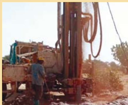
Die Arbeiten zur Brunnenbohrung gehen zügig voran
