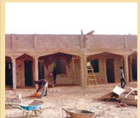
Boulsa Klinik im Rohbau
