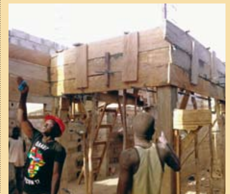
Arbeiter bei der Boulsa Klinik
