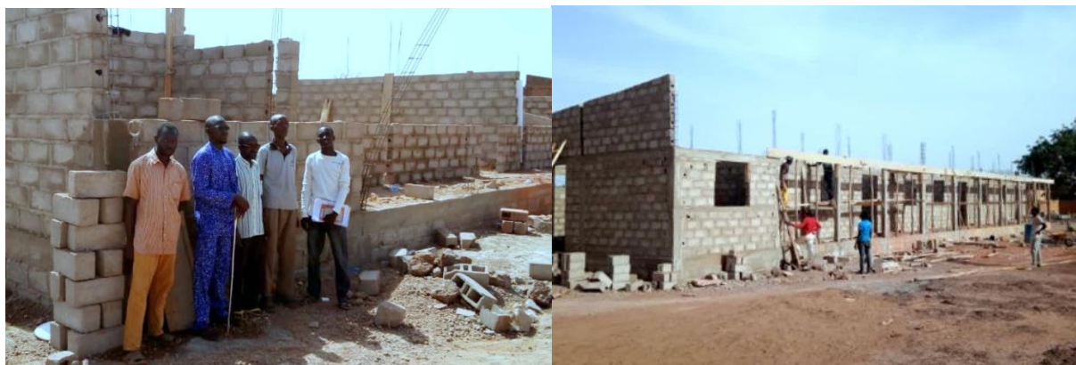
Bauarbeiten im März/April 2021 in Ouagadougou/Burkina Faso
