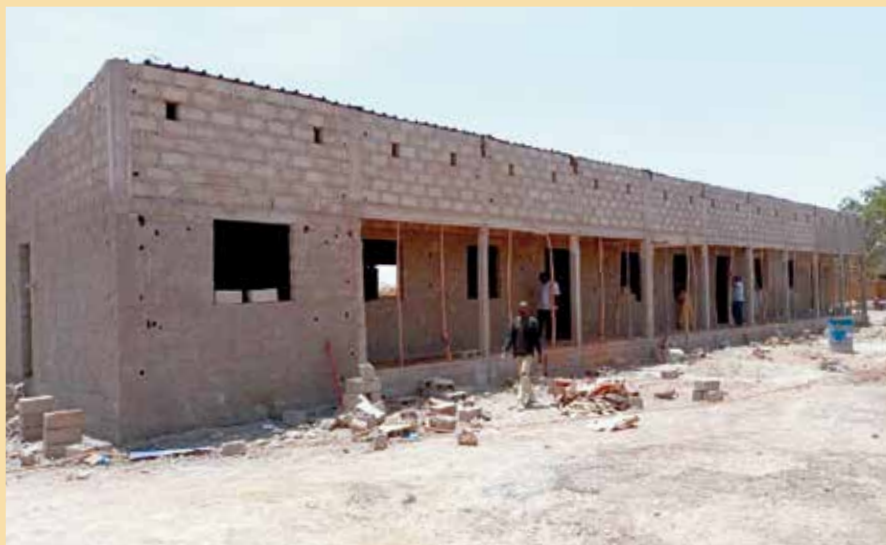
Die drei neuen Klassenräume der Schule in Ouagadougou im Rohbau
