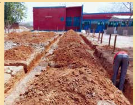
Umfassungsmauer in der Bauphase
