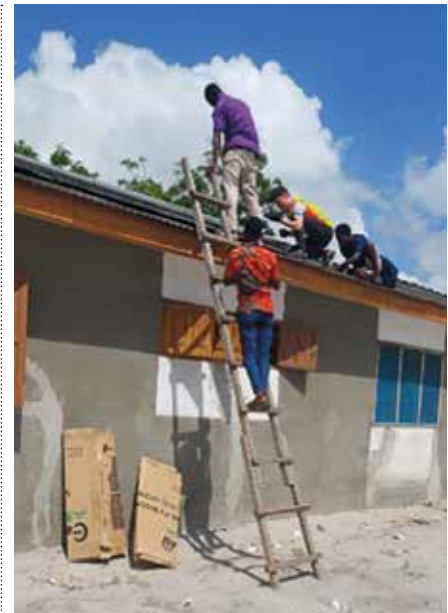
Arbeiten an der Photovoltaikanlage
